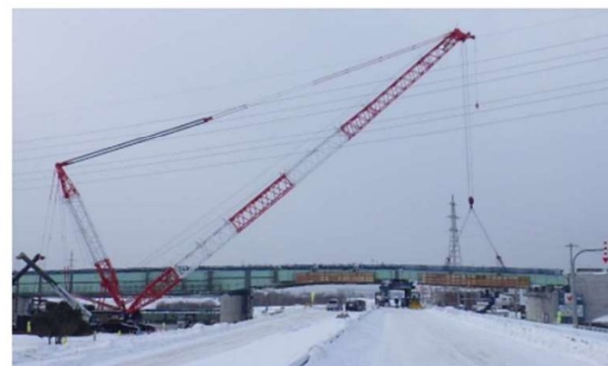
令和3年1月北24条大橋架設（札幌市）
