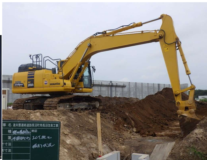
ICTによる掘削
