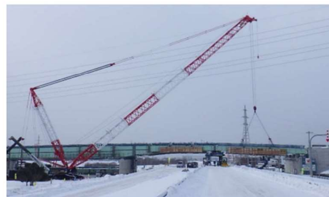
令和3年1月北24条大橋架設（札幌市）
