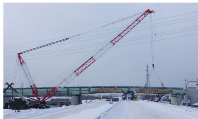
令和3年1月北24条大橋架設（札幌市）
