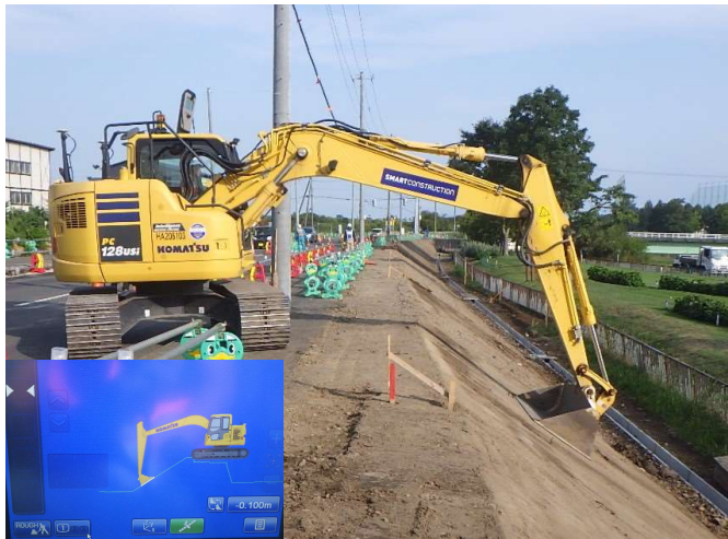
ICTによる法面整形（札幌市）
