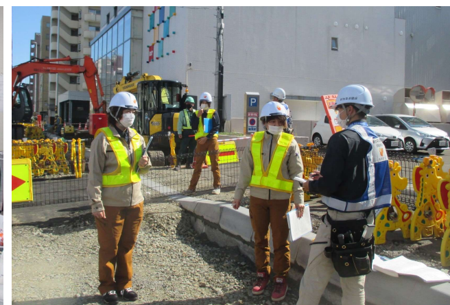
札幌市電線共同溝工事
