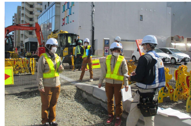
札幌市電線共同溝工事
