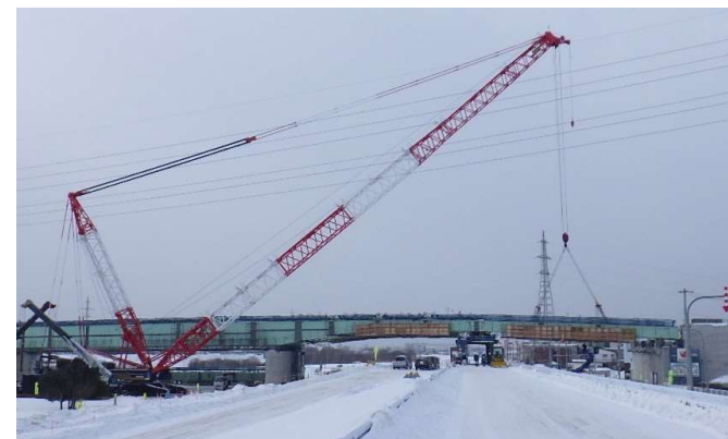
令和3年1月北24条大橋架設（札幌市）
