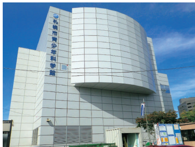
青少年科学館改修(札幌市)
