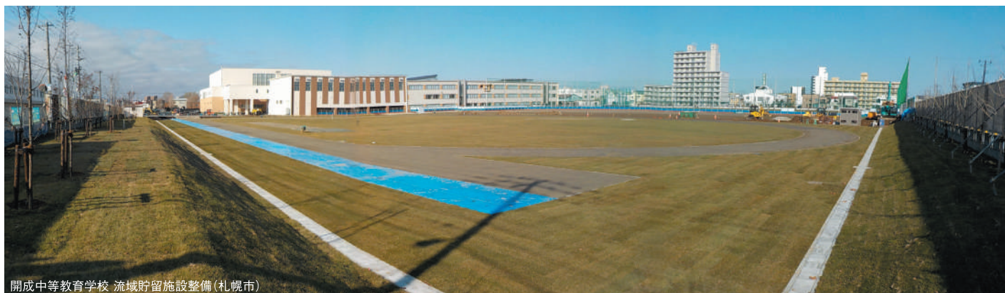
開成中等教育学校 流域貯留施設整備(札幌市)
