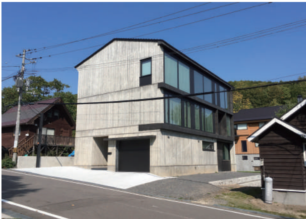
コンドミニアム HIGUMA Rebuild(倶知安町)
