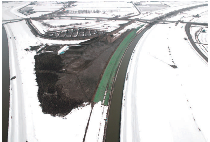
幾春別川右岸河岸保護(岩見沢市)
