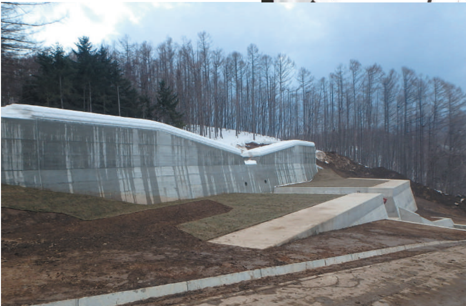
南の沢川第11号溪流堰堤(札幌市)
