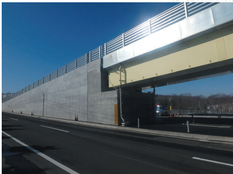
国道36号輪厚改良(北広島市)
