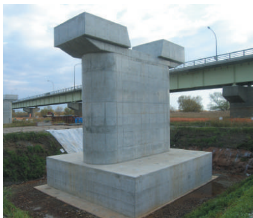
国道275号新石狩大橋下部工(江別市)
