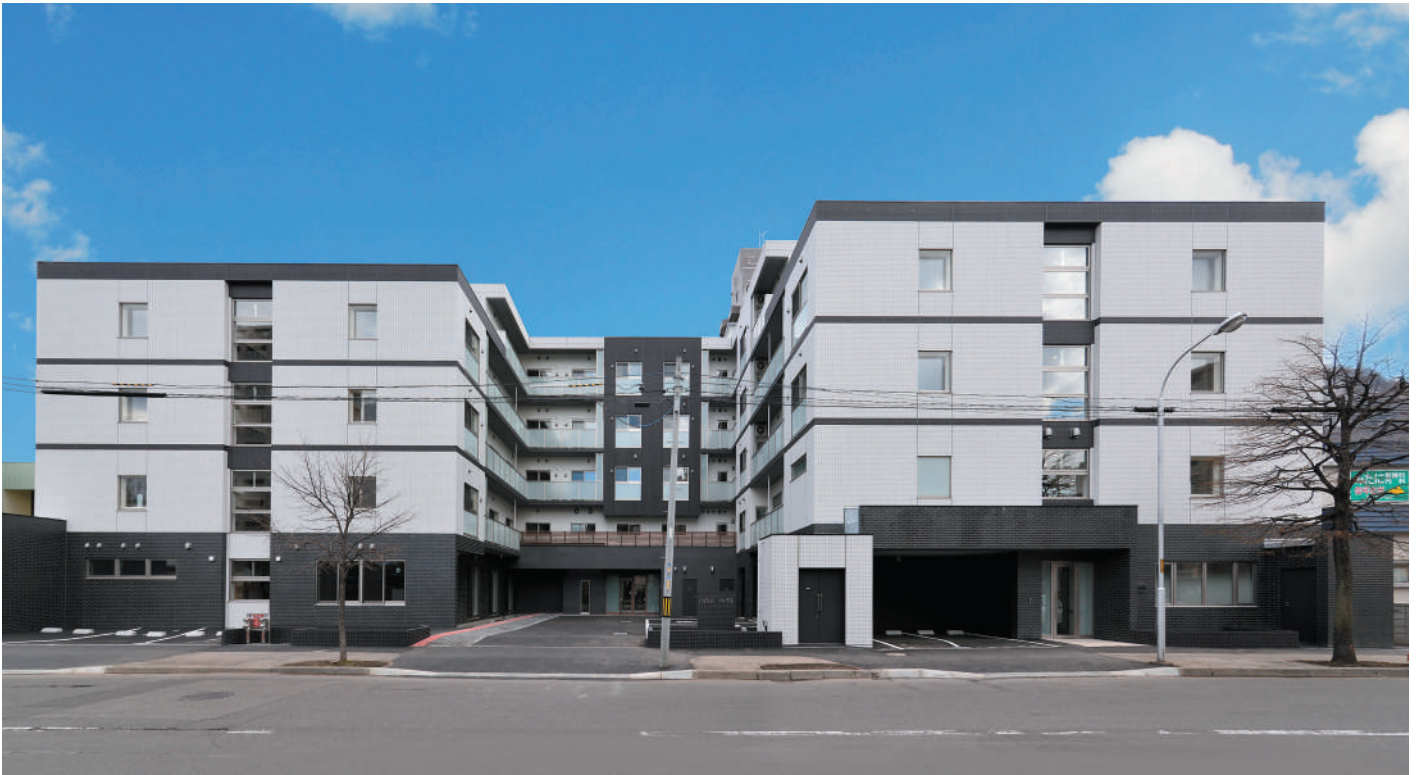
住宅型有料老人ホーム ネクサスコート旭ヶ丘(札幌市)
