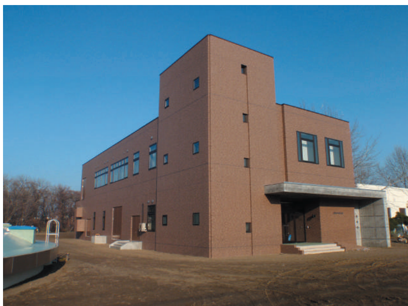
新港中央配水場(石狩市)
