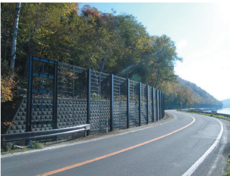
国道453号支笏落石防護柵設置(千歳市)
