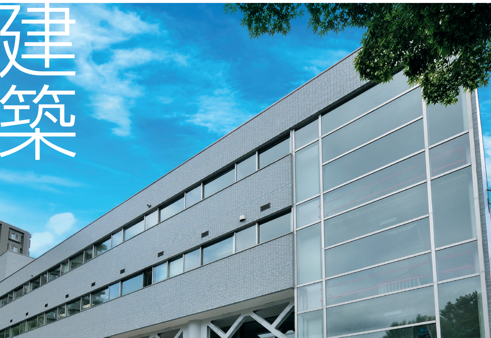
水産研究所庁舎耐震改修(札幌市)
