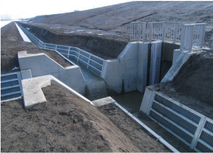
嶮淵川南12号樋門改築(長沼町)
