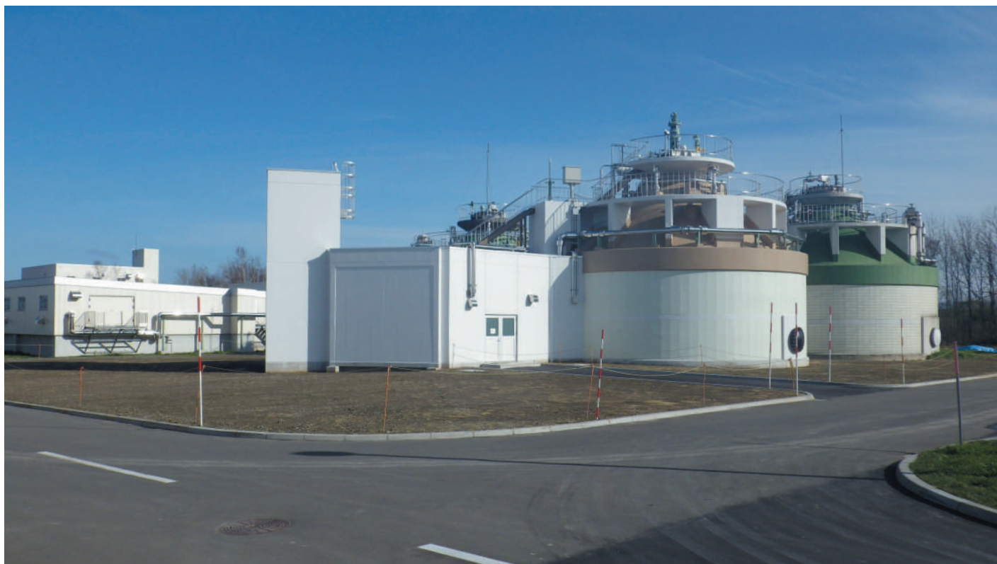
下水処理センター(北広島市)
