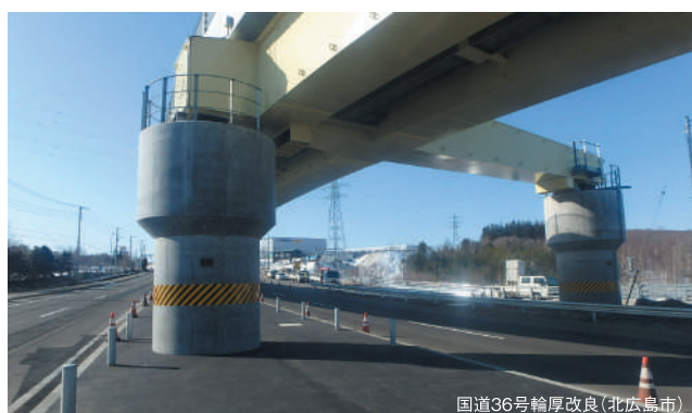
国道36号輪厚改良(北広島市)
