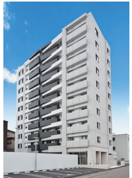
クルーザーパレー白石南(札幌市)
