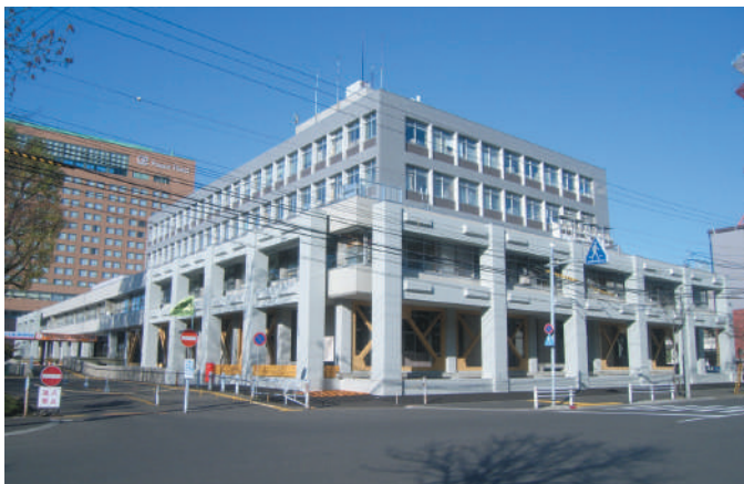
釧路市本庁舎耐震改修(釧路市)
