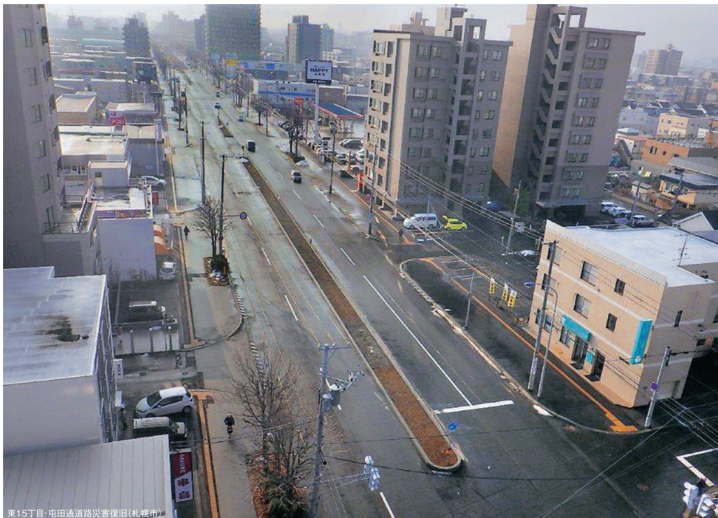
東15丁目・屯田通道路災害復旧(札幌市)
