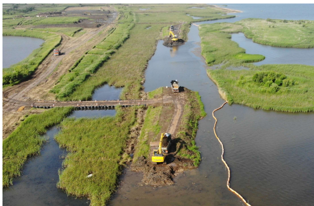
令和2年7月矢臼場河道掘削（石狩川）
