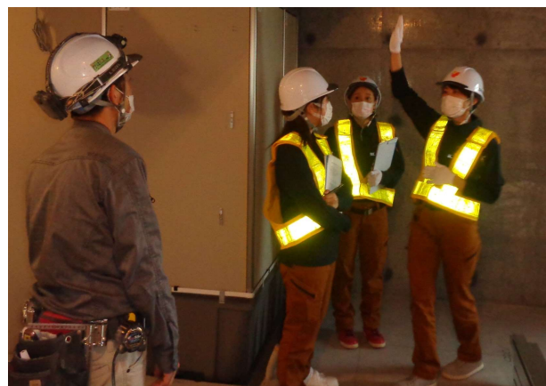
マンション建築工事（令和2年9月）
