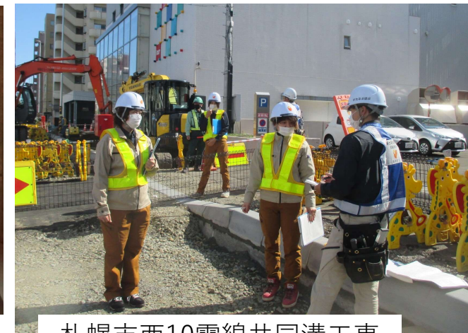
札幌市西10電線共同溝工事 （令和3年10月）
