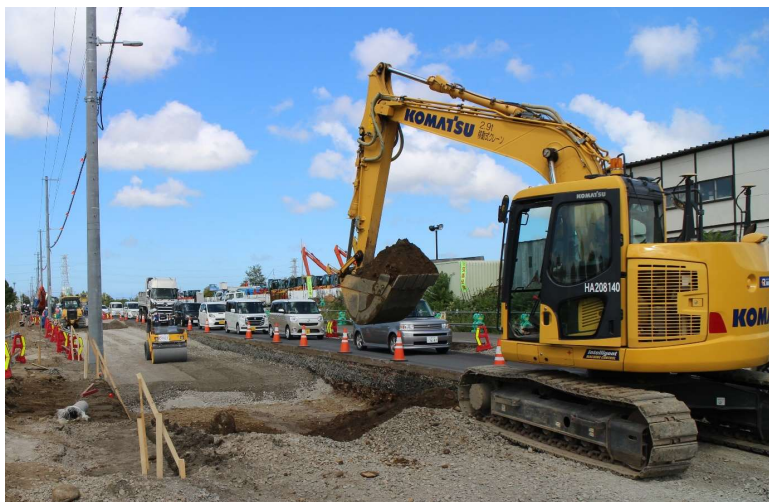
ICTによる道路造成（札幌市）
