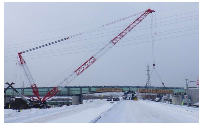
令和3年1月北24条大橋架設（札幌市）
