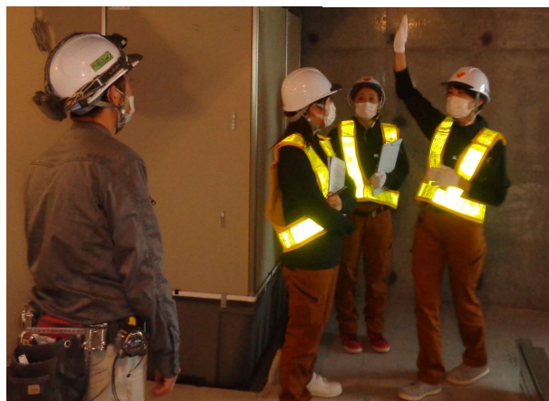
マンション建築工事 （令和2年9月）
