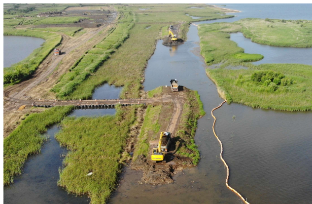
令和2年7月矢臼場河道掘削（石狩川）
