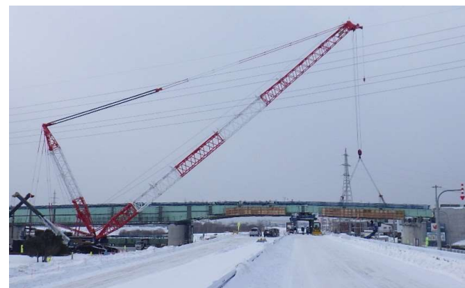
令和3年1月北24条大橋架設（札幌市）
