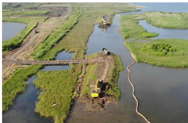
令和2年7月矢臼場河道掘削（石狩市）
