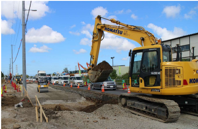
ICT施工による道路造成（札幌市）
