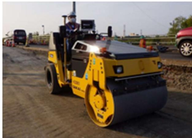
ITC施工による道路造成（札幌市）
