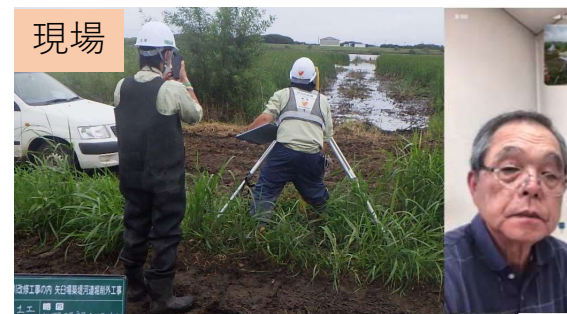
リモートによる掘削箇所の段階確認
